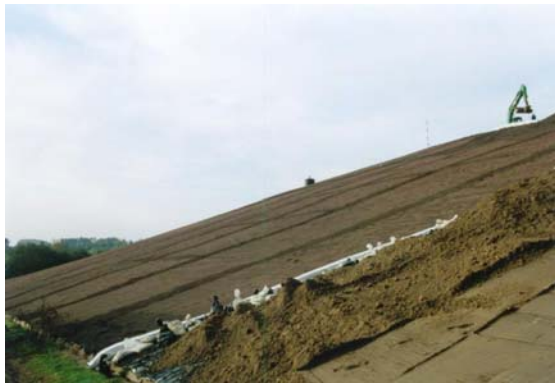
Bild 8: Die Kabel sind strangförmig im Auflager eingegraben.
