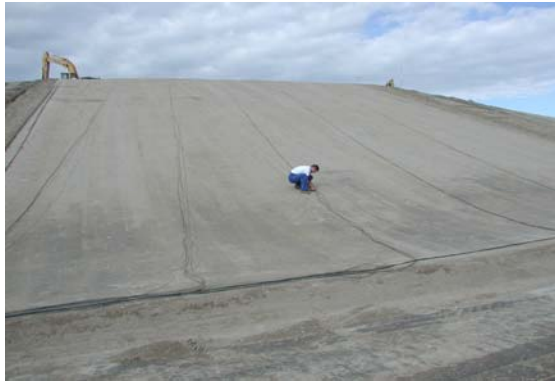
Bild 20: Verlegte Sensoren im Probefeld.
