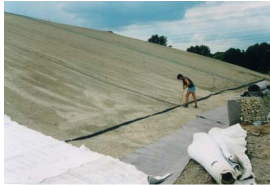
Bild 7: Die Kabel verlaufen in Strängen.
