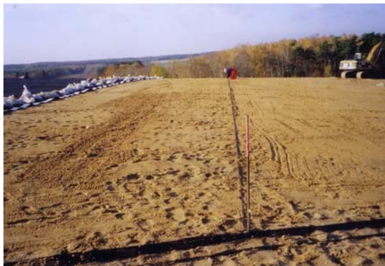
Bild 16: Verlegte Sensoren und Kabel.
