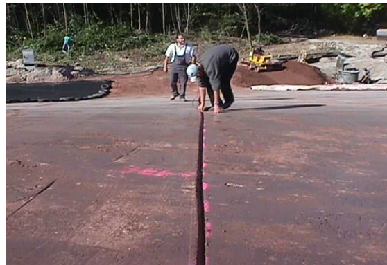
Bild 9: Die Kabel werden in Rillen eingelegt.
