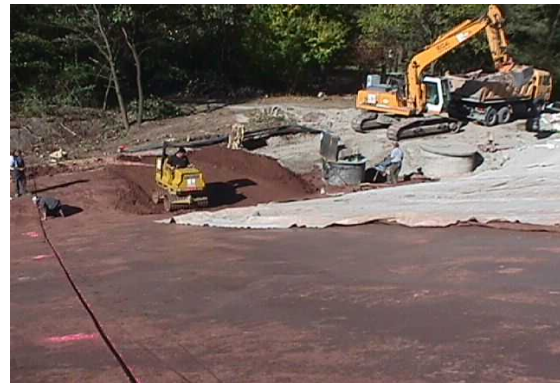
Bild 19: Die Kabel verlaufen in Rillen.
