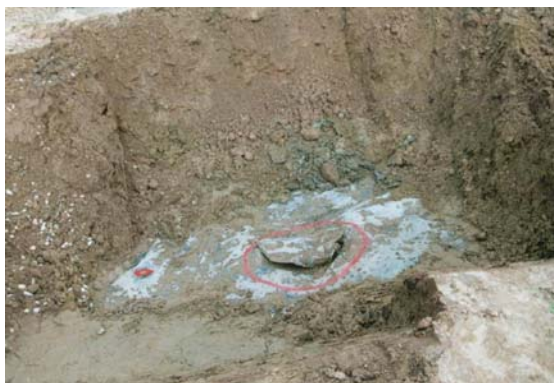
Bild 14: geortete Beschädigung
