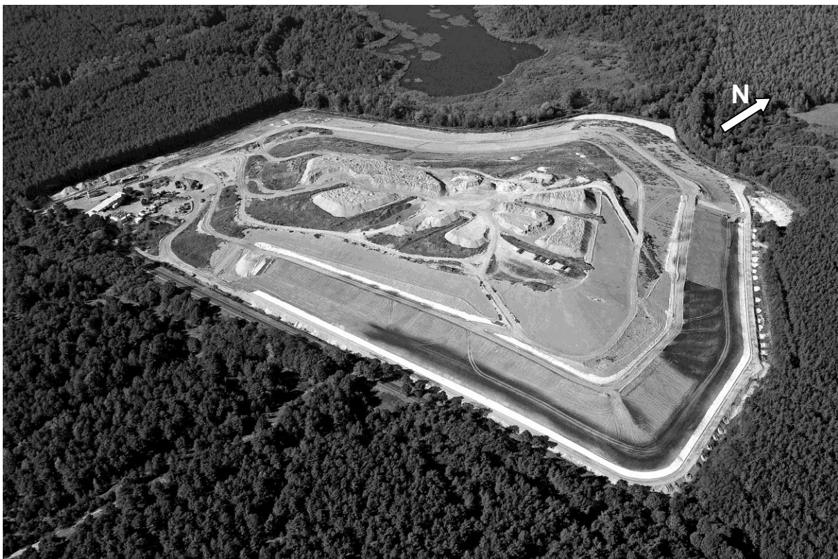
Abb.1: Die fast fertig profilierte Deponie Wernsdorf und angrenzende Gebiete. Die untere Böschung im Vordergrund vom Eingangsbereich (links) bis zum Versickerungsbecken (rechtsoben) wurde im Zuge des 1. BA abgedichtet. Im Kuppenbereich sind die Schlackehaufwerke zu erkennen, die dort für den Einbau als Trag-/ Ausgleichschicht vorgehalten werden.
