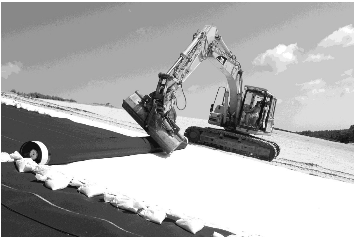
Abb. 3: Verlegen der oberen Kunststoffdichtungsbahn auf dem Trennvlies.
