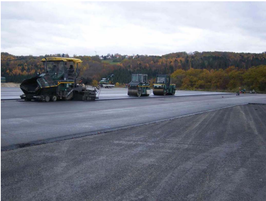
Bild 1: DAD - Einbau in der Verebnungsfläche
