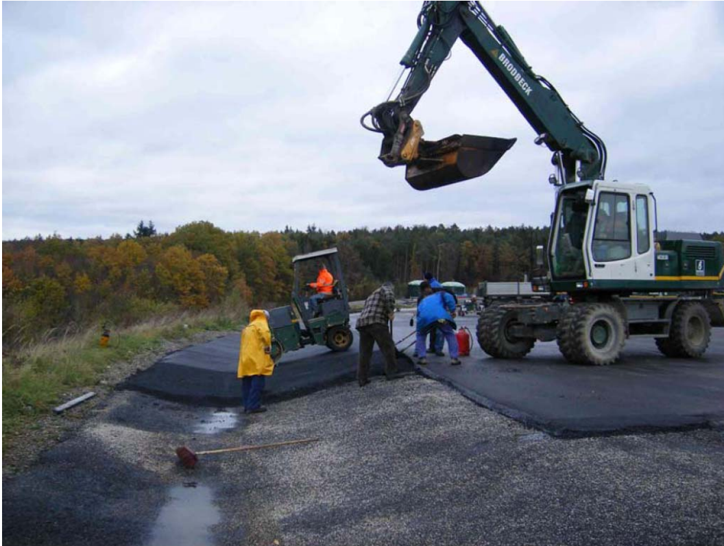
Bild 2: Asphaltmuldeeinbau
