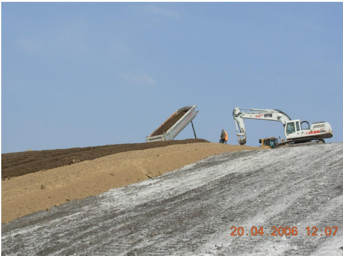
Probefeld - Aufbau Wasserhaushaltsschicht
