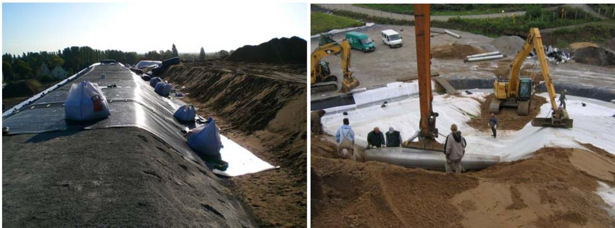
Abb. 5: Ausführung eines Geogitter-Verankerungsgrabens an der Berme (links) und im Kurvenbereich (Flankengraben, rechts)
