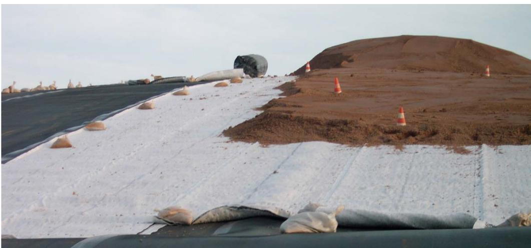
Abb. 1: Einbau der Rekultivierungsschicht auf einer Dränagematte mit BAM-Eignungsnachweis
