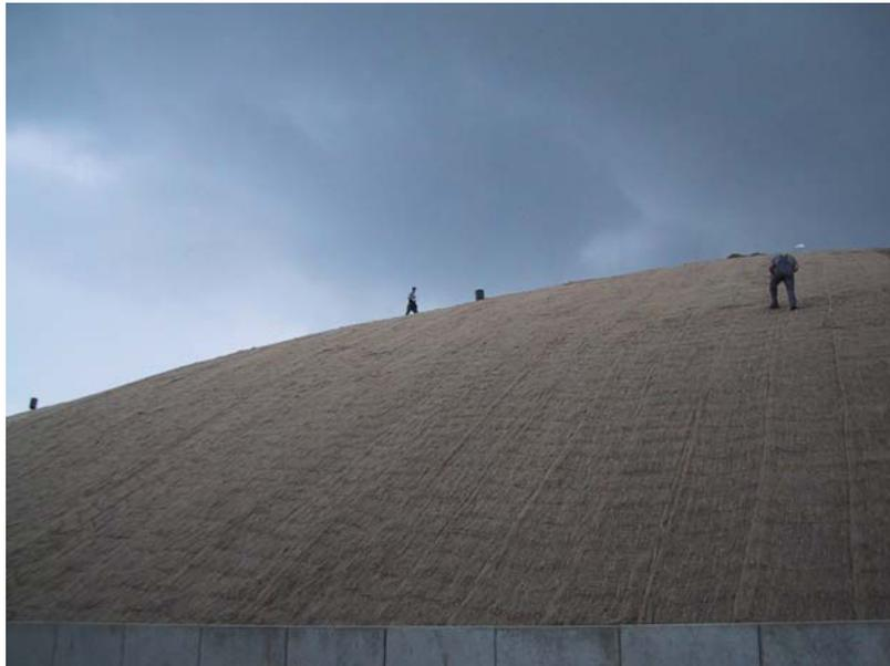
Abb. 4: Erosionsschutzmaßnahmen an der Oberflächenabdichtung der Deponie Furth im Wald (2005)
