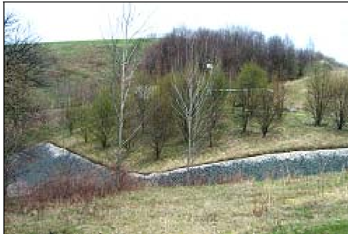
Abbildung 4.4: Deponie Schneidenbach – fertiggestellter Böschungsbereich mit Bewuchs
