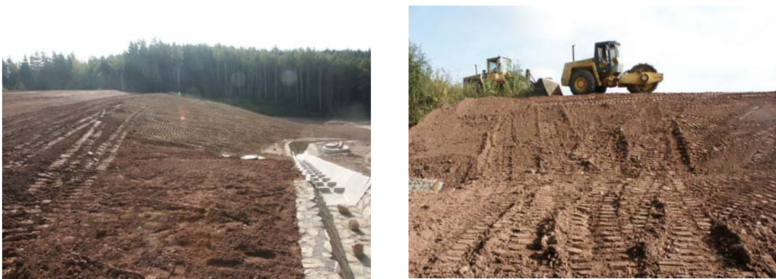
Abbildung 4.7: IAA Lengenfeld – Einbau der Wasserhaushaltsschicht und Zwischenlager für Material der Wasserhaushaltsschicht
