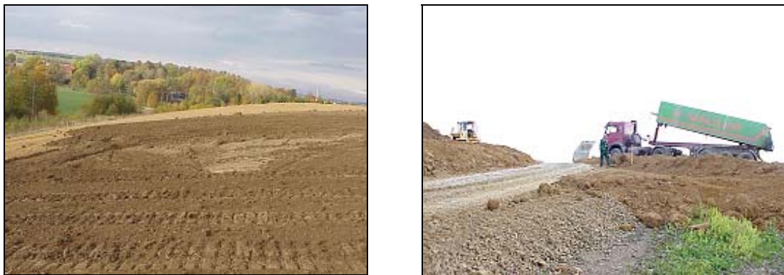
Abbildung 4.3: Deponie Falkenstein – Einbau der Wasserhaushaltsschicht
