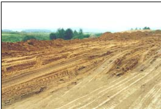
Abbildung 4.5: Deponie Schneidenbach – Zwischenlager für Material der Wasserhaushaltsschicht
