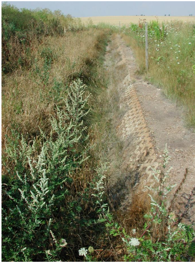
Abb. 3: Ringgraben um die Deponie (August 2003)
