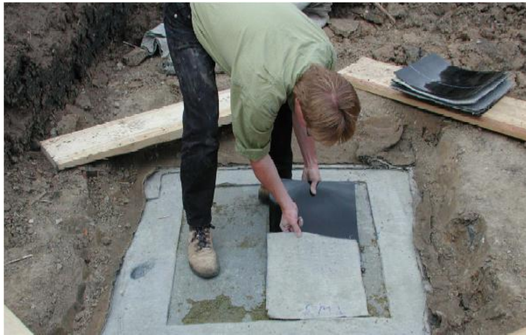
Abb. 6: Probenentnahme aus der Bentonitmatte (Bentofix NSP 4900-1) für die Laboruntersuchungen
