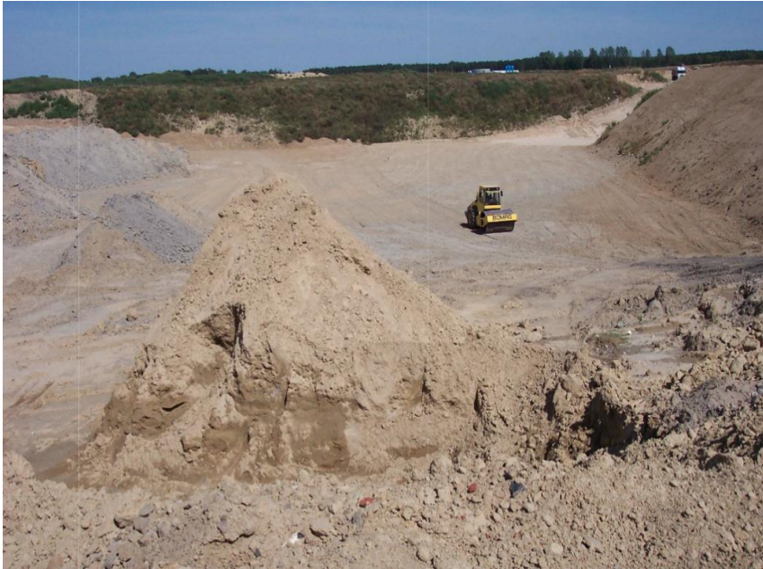
Abbildung 2: Tagebaurestloch (Kies-/Sandabgrabung), Herrichtung der Aufstandsfläche für eine Deponie DK I
