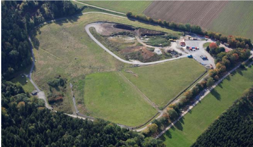
Abb. 1: Luftbild der Deponie „Lichte“, Kaisersbach mit Abgrenzung der bereits oberflächengedichteten Bereiche
