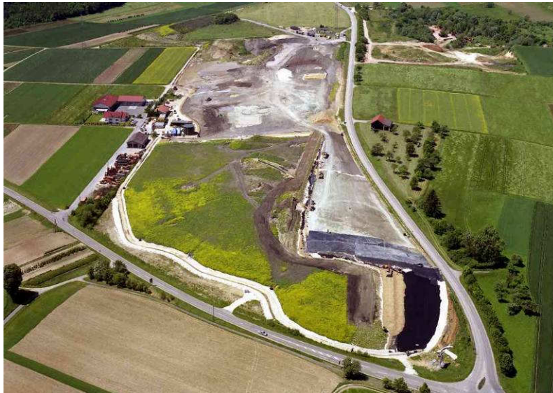
Abb. 1: Deponie Eggingen Bauausführung 2006
