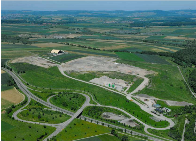
Abb. 13: Mineralstoffdeponie „Am Froschgraben“
