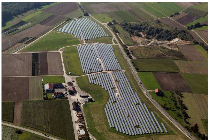
Abb. 4: Luftbild PV-Anlage Deponie Eggingen
