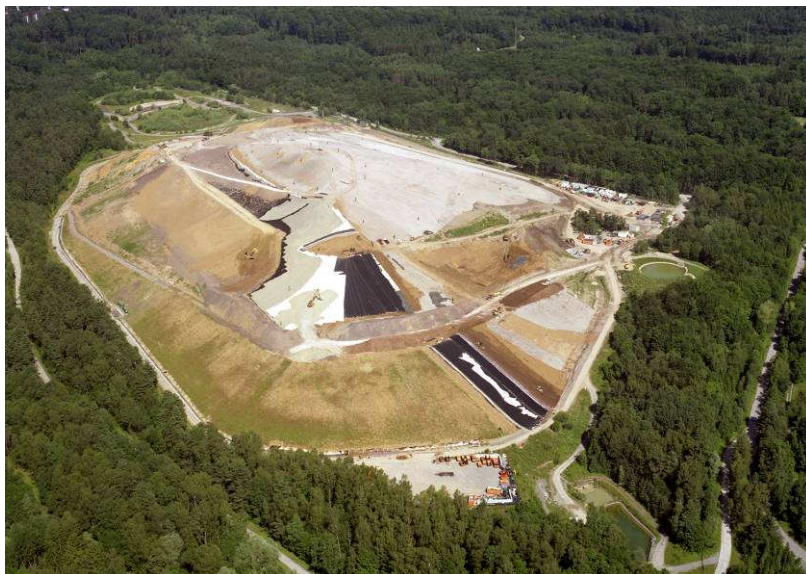
Abb. 5: Deponie Böblingen, Blickrichtung Südost
