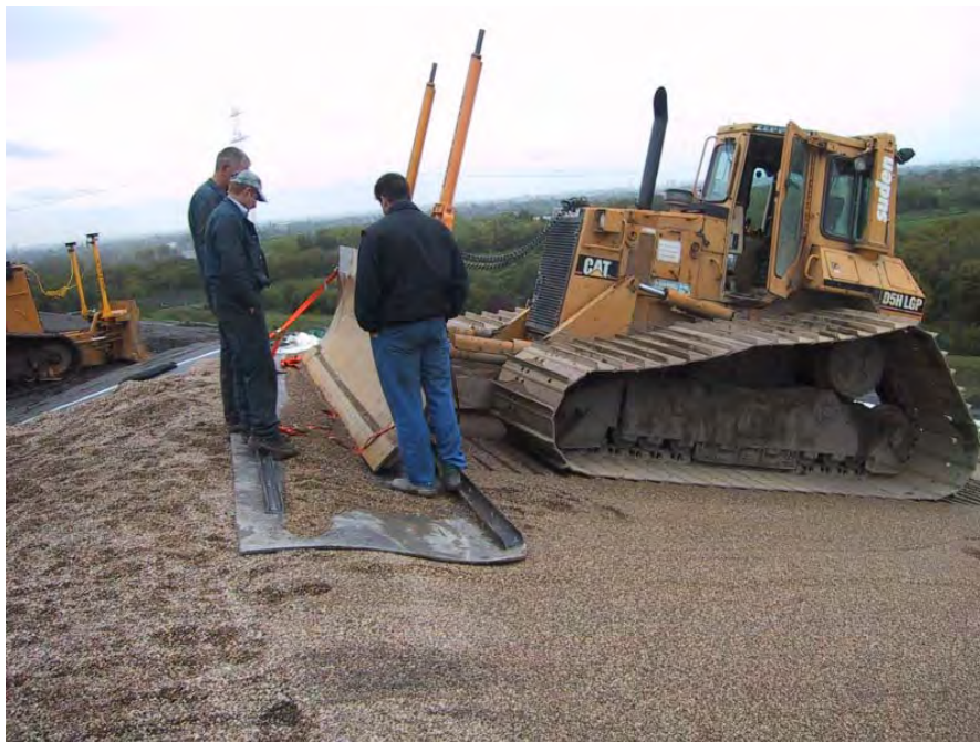
Bild 7: Moorraupen mit Schleppbalken und Gummilippen
