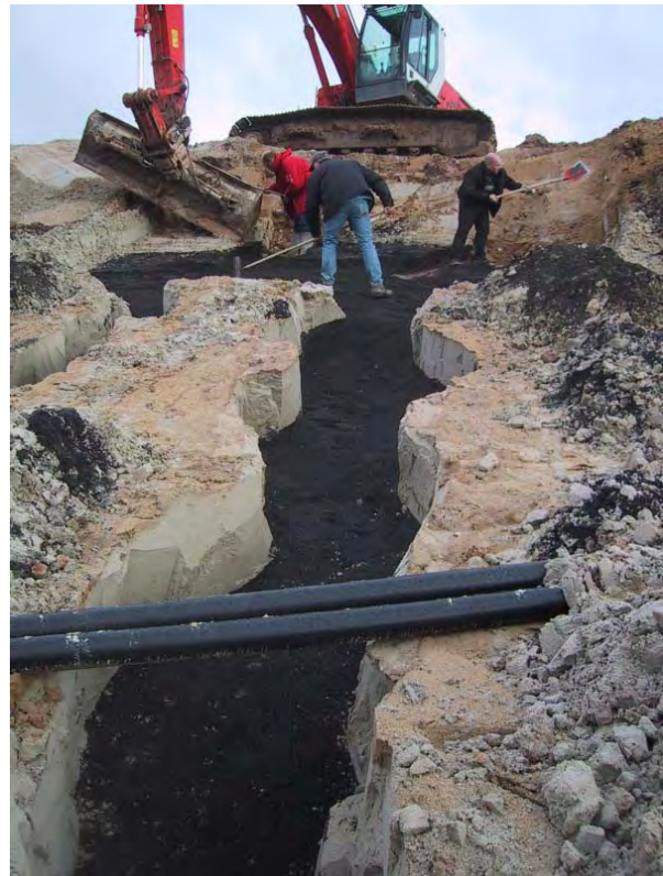
Bild 10: Sanierungsarbeiten der Erosionsrinne
